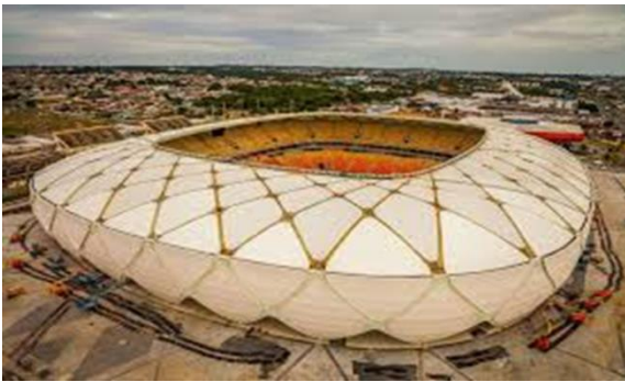
Figure (15) represents Arena de Amazonia Stadium (Arena da Amazônia / gmp Architekten , 2017)
